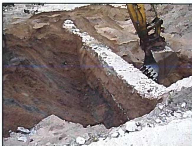
Figure 3 : Découverte de murs de fondation enterrés
