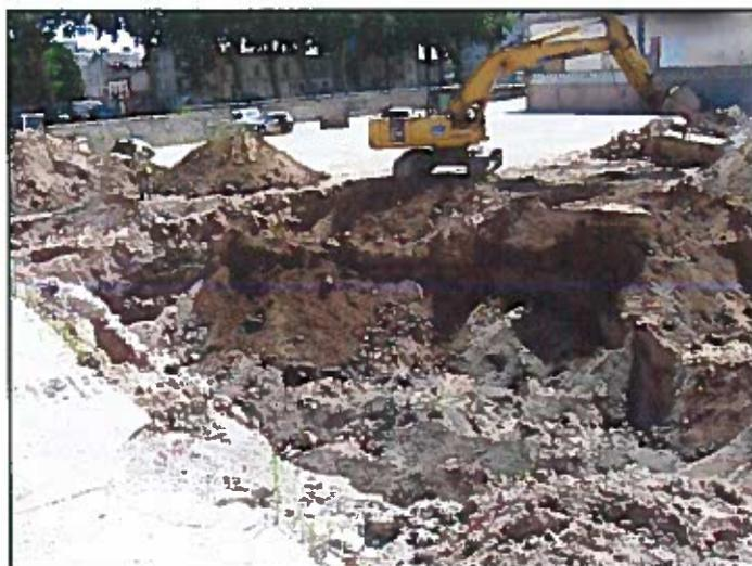
**Figure 1 : Phase d'excavation des terres souillées**
